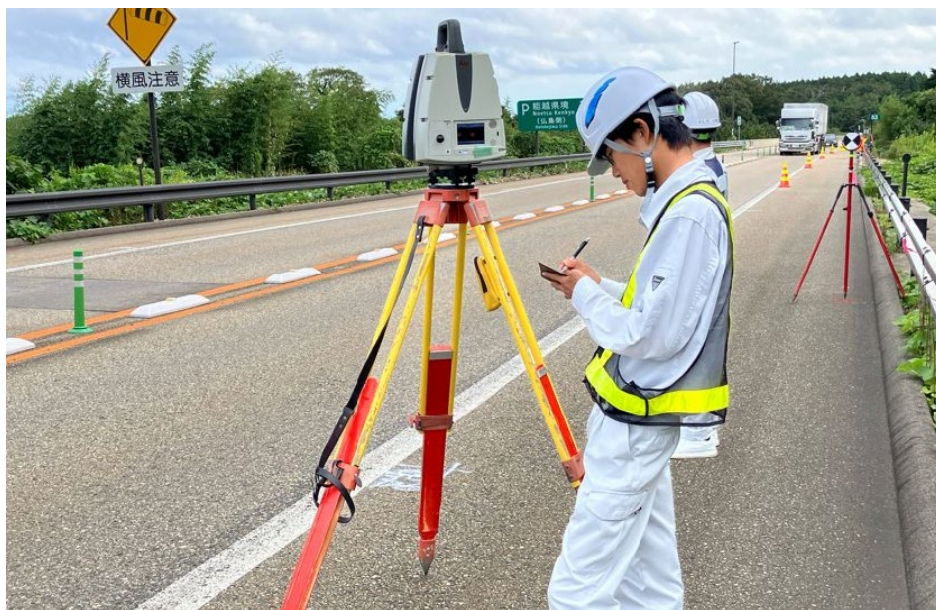
写真 2：路肩部規制による 3 次元測量
