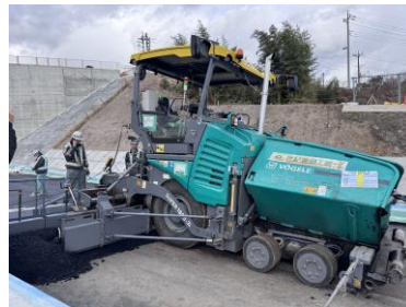
写真-10 AF 運転手無人での施工状況
