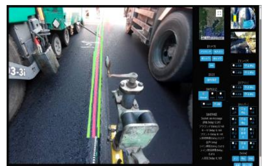
写真-7 切削端部における AI 認識状況
