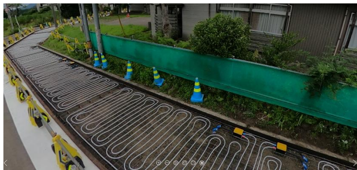
写真 6-1 放熱管敷設完了状況
