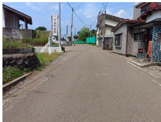
写真 4-1 現地着手前状況
