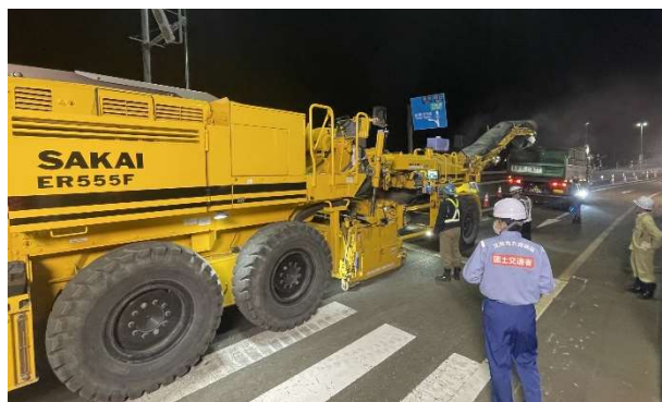
写真-2 路面切削施工状況
